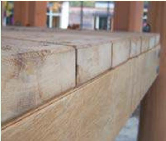
Die Bodenbeläge und Podestunterzüge sind aus resistenten, großzügig dimensionierten, kerngetrennten Eichenhölzern gefertigt.
